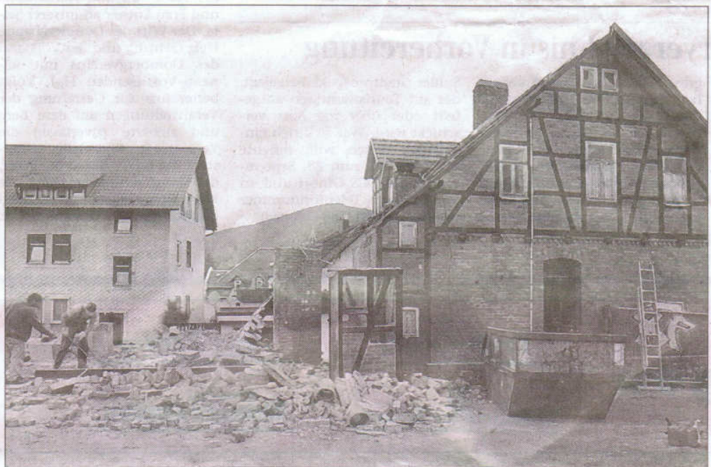
Auch das Wohnhaus mit ausgemauertem Fachwerk (r.) wird abgetragen. FOTO: frankphoto.de
